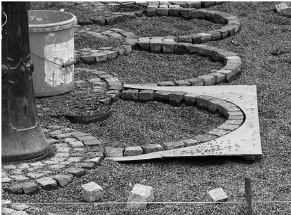
Eine Kunst für sich: Planung und Verlegung eines Schuppenverbandes.(o.r und r). Hilfreich sind Schablonen in der Größe der fertigen Schuppe (o).
