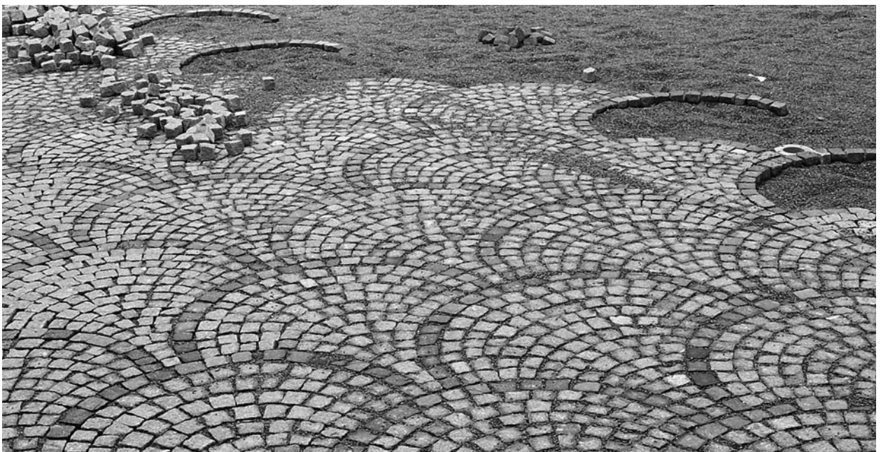
Ausgehend von zwei nebeneinander liegenden Halbkreisen werden die Scheitelpunkte wieder mit einem Halbkreis verbunden.
