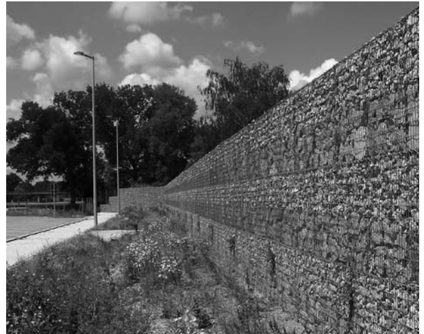
Lärm- und Sichtschutz mit Gabionen.
