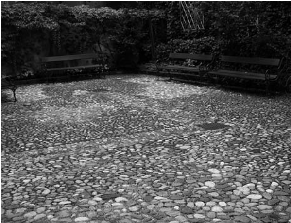
Natursteinbelag aus Kiesel.
