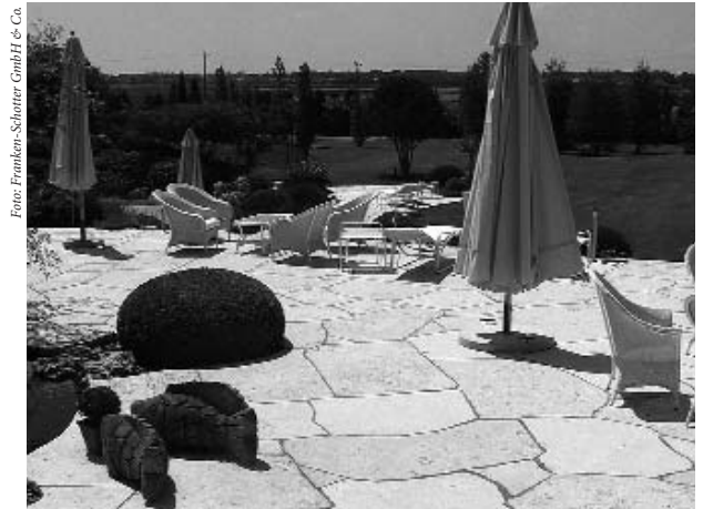
Unregelmäßiges Fugenbild: Polygonalverband.
